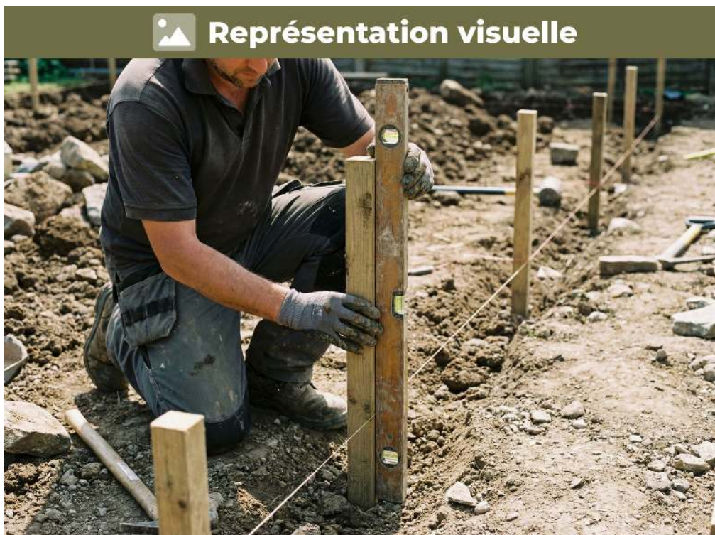
Utiliser un niveau pour une précision de 0,5 cm lors de la pose des piquets
